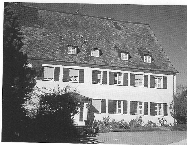
Das Wohnhaus der Klötzenmühle
